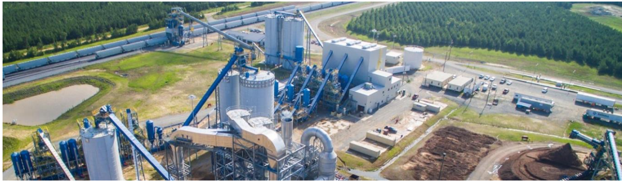
Figura 13: Esempio di centrale a biomasse - Drax, United Kingdom – 4,000 MW
